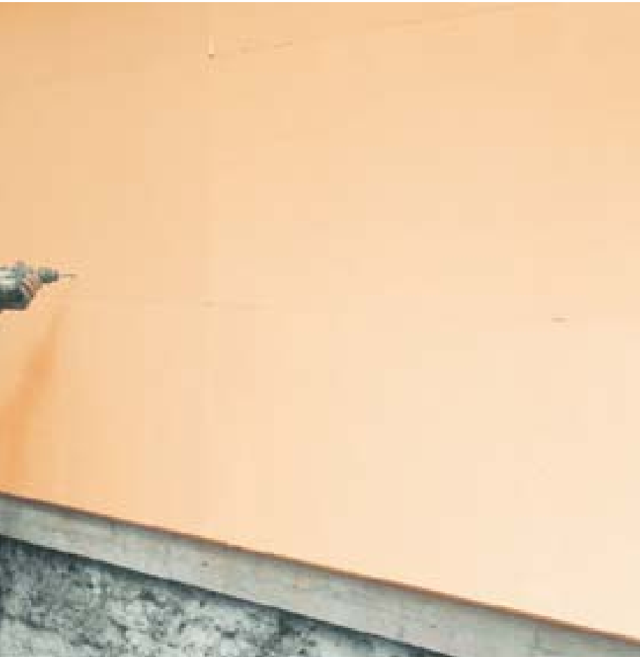
Instalación Polyfoam en cerramiento vertical
