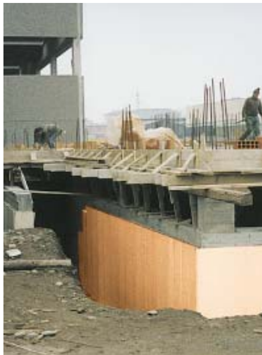
Protección muros enterrados
