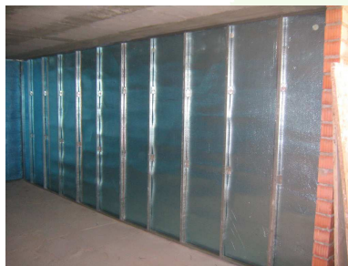
colocación para pladur
